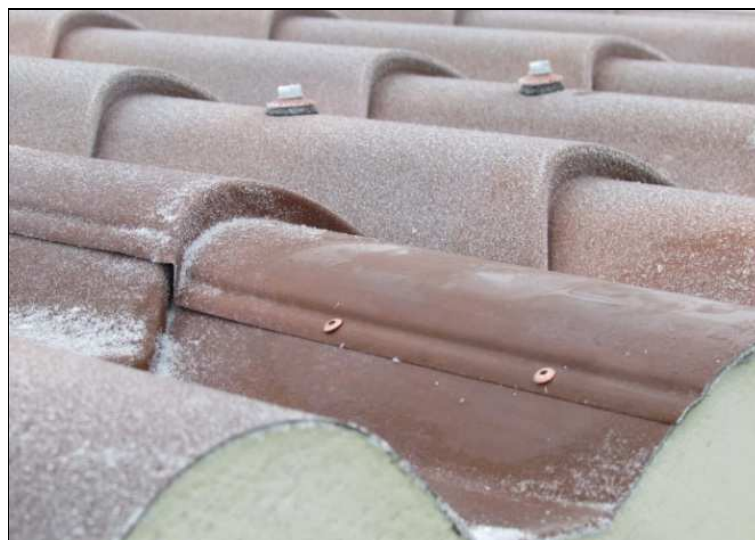
Esempio di corretto impiego di rivetti
