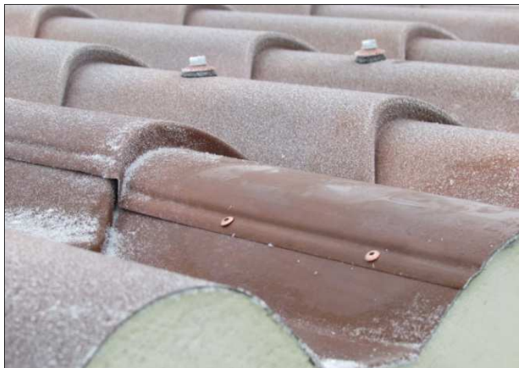
Beispiel des korrekten Einsatzes der Nieten
