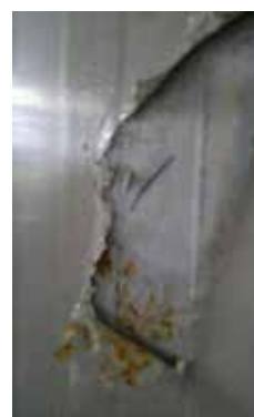
Ejemplo de oxidación sucesiva a un fenómeno de blistering
