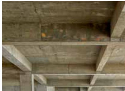
FLACHDACH AUS TONHOHLPLATTEN
